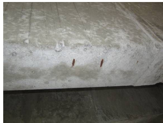
横隔板局部露筋
