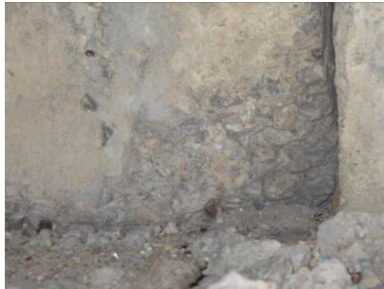
T 梁梁端底部砼崩裂剥落
