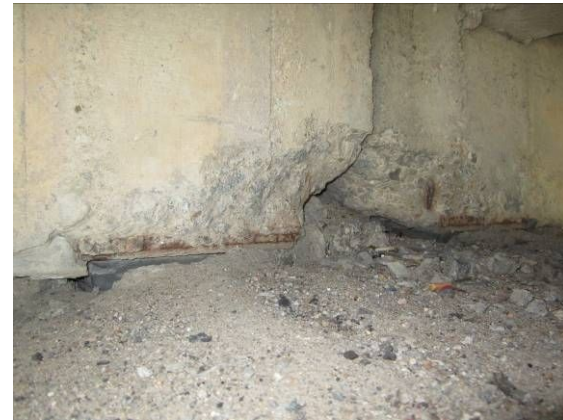
T 梁梁端底部砼崩裂剥落
