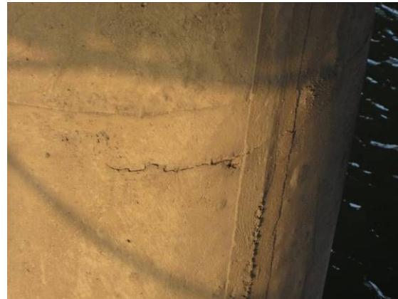
立柱钢筋轻度锈胀，砼剥落
