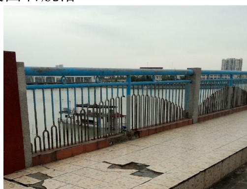
镀锌钢管锈蚀缺损
