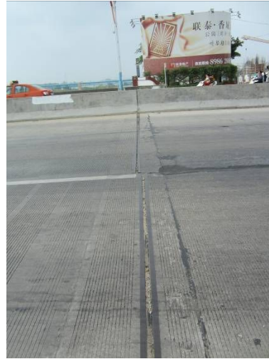
伸缩缝被泥沙塞死
