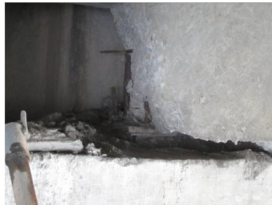
T 梁梁端底部砼崩裂剥落
