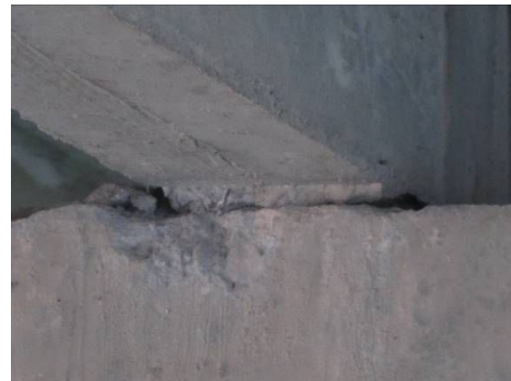
旧桥梁底突出致盖梁受损
