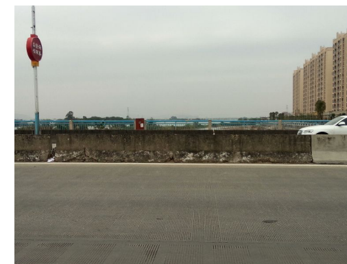
砼护栏局部破损
