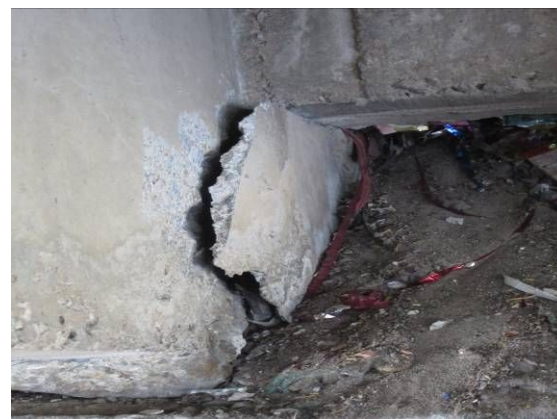
旧桥支座被垃圾堵塞致梁受损
