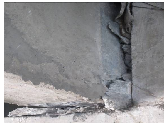
T 梁梁端底部砼崩裂剥落
