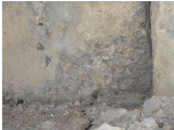
T 梁梁端顶死、崩裂
