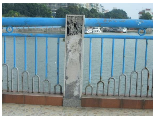
栏杆立柱镶面石脱落
