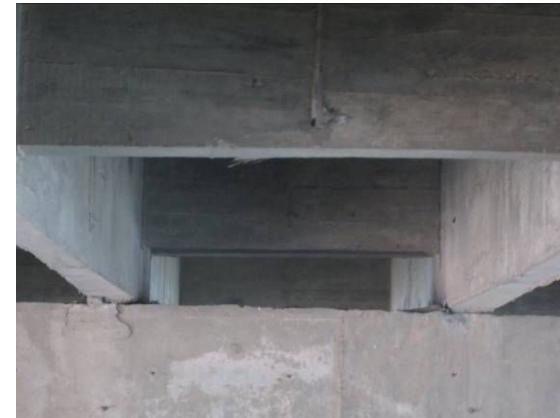
梁底突出致盖梁受损
