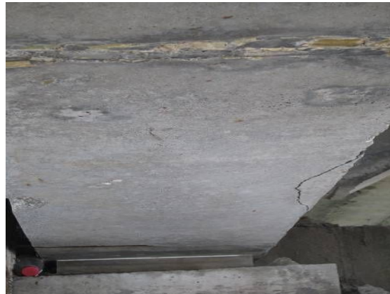
Z19-4#梁梁端砼撞损剥落
