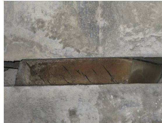
新桥支座严重材料老化、剪切变形
