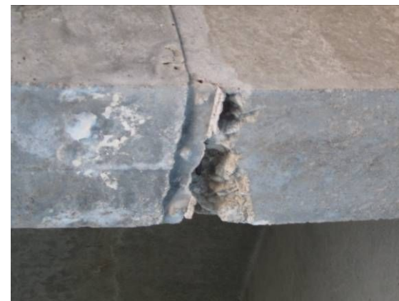
横隔板砼局部剥落
