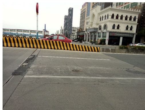
42#台搭板破碎、开裂
