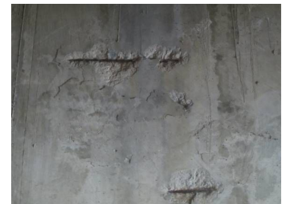
T 梁钢筋锈胀，砼剥落
