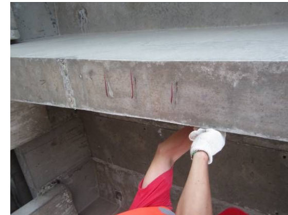
T 梁局部轻度露筋
