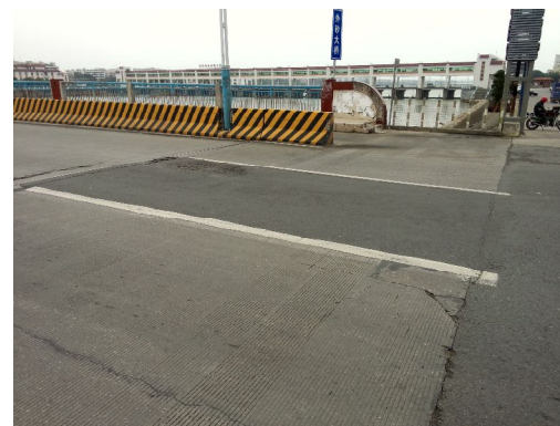
42#台搭板破碎、坑槽、开裂
