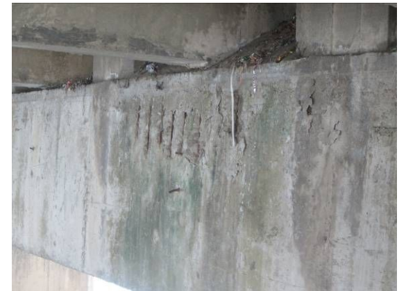
36#盖梁受潮钢筋锈胀，砼剥落
