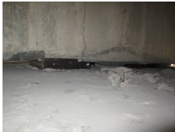
旧桥支座轻度剪切变形
