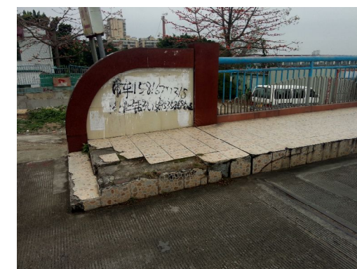
人行道瓷砖破损缺失
