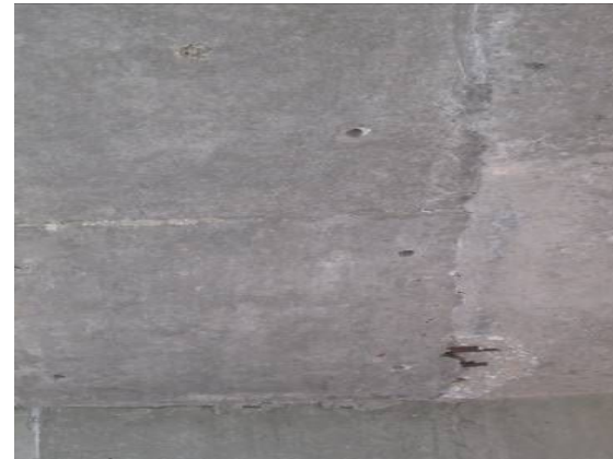
Y19-4#梁翼板轻度露筋
