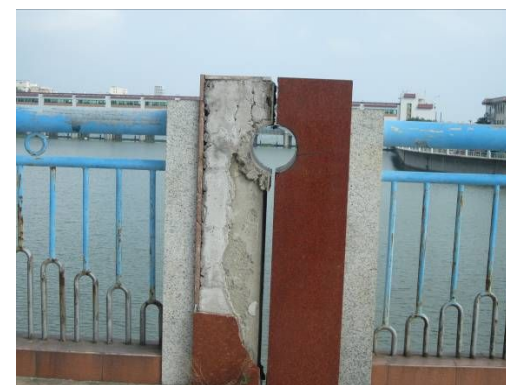
栏杆立柱镶面石脱落
