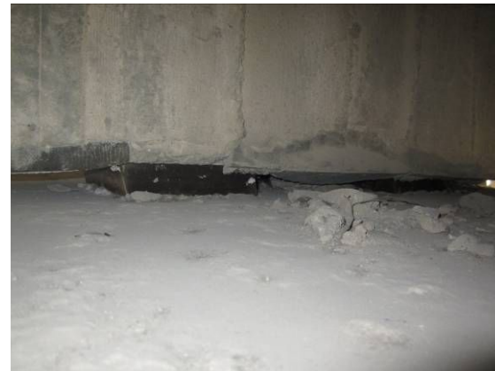
T 梁在墩顶砼连接
