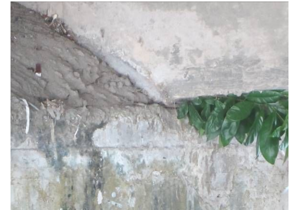
新桥支座被堵塞封闭
