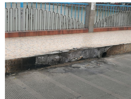
人行道瓷砖破损缺失
