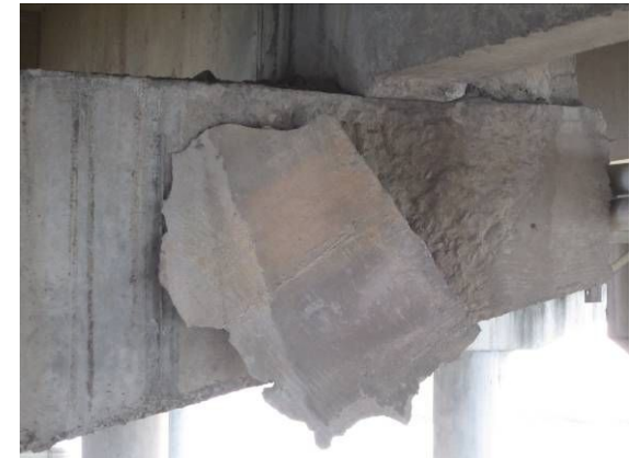
25#盖梁严重受损，砼大面积崩落
